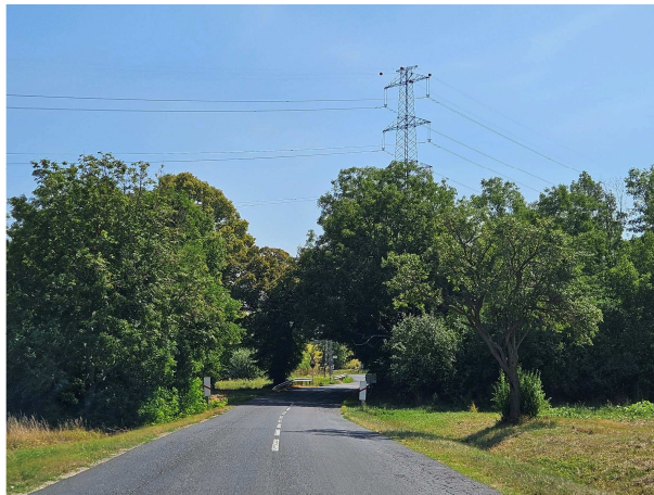
A 400 kV-os tárvvezeték, a fák között a 17-es vasútvonallal
